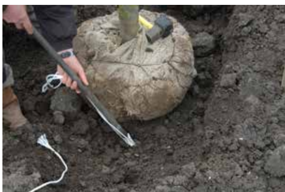
3. Breng de keeper d.m.v. de drijfstang aan in de grond.
