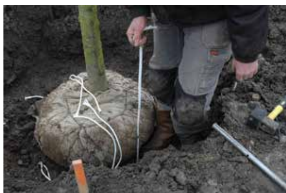
4. Trek aan het zojuist ingebrachte touw. De keeper kantelt hierdoor en zet zich vast in de grond.
