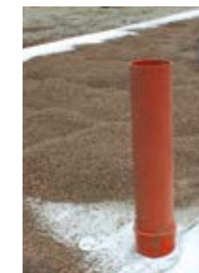
Bovengrondse sectie van een verticale inspectiebuis dn 200 mm
