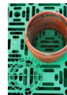
Plaatsen van een 200 mm PVC-U buis in de opening
