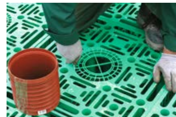
Uitsnijden van het raamwerk voor een dn 200 mm aan bovenzijde box
