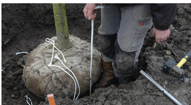
4. Trek aan het zojuist ingebrachte touw. De keeper kantelt hierdoor en zet zich vast in de grond.
