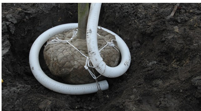
6. Breng de Natudrain buis aan. Dit voorziet de boom van de nodige beluchting.
